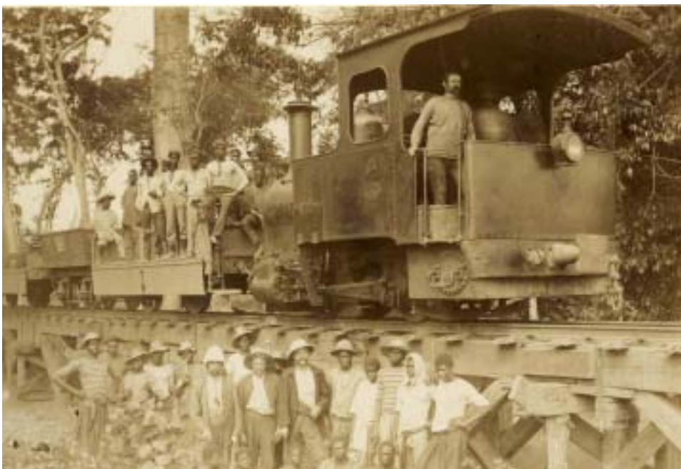
Foto 15: de aanleg van de spoorlijn Matadi-Leopoldstad. Neder-Congo, 1893-1897
