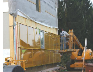
3.1 Houtskeletelement met gevelafwerking en ventilatie-unit met warmtewisselaar
