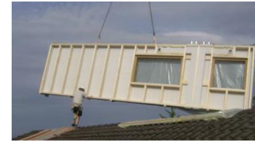
1.4 Houten caisson met houtvezelplaat en ventilatiekanalen
