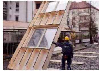
1.2 Houten caisson met gipskartonplaat
