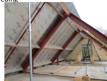
4.3 Isolatieplaat met meerlaagse aluminium bekleding
