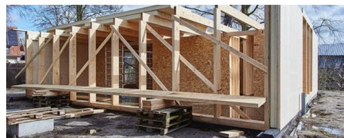
4.1 SIP met multiplexlagen als wand- en gevelafwerking
