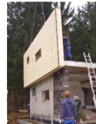
1.3 Houten caisson met vezelplaat en geventileerde gevel
