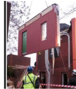
2.2 Enkelschalig betonelement met minerale wol
