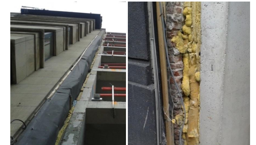
Figuur 85 Aansluiting met de burens vormden hier een extra uitdaging
