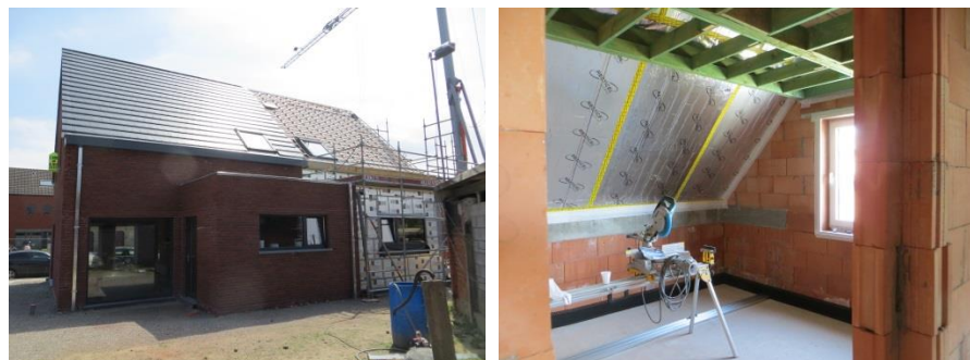
Figuur 14 (a) De twee BEN-woningen (b) Gordingenstructuur in hout
