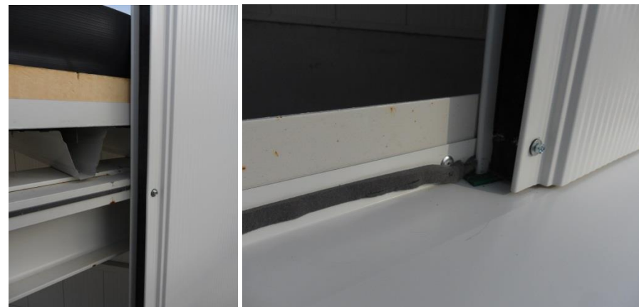
Figuur 66 Schroefverbinding in de voeg (verborgen verbinding)
