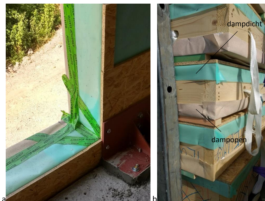
Figuur 52 (a) De dampopen en dampdichte folie zijn samengetapet om de folies te beschermen tijdens transport. (b) Panelen tijdens transport
