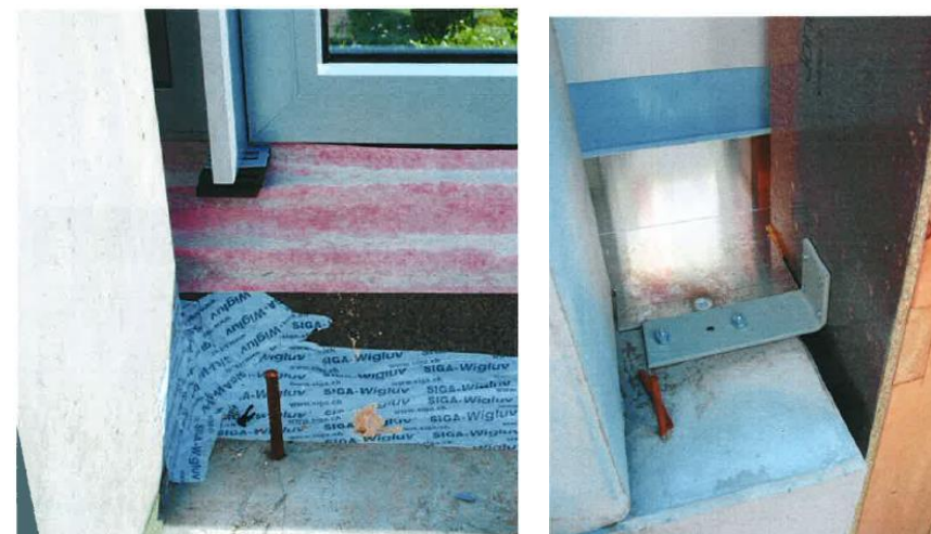
Figuur 43 Uiteindelijke uitvoering met luchtdichte tape. Op sommige plekken was de tussenruimte te groot om goed af te plakken, maar te klein om extra isolatie te voorzien (rechts) (De Preter, BB, 2017).
