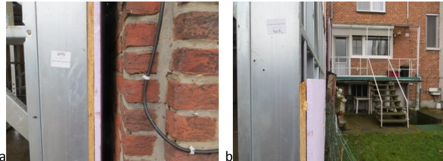
Figuur 1 Aansluiting op de burens met OSB en PIR voor de akoestiek
