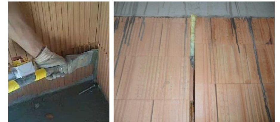
Figuur 9(a) Voegen worden opgevuld met lijm mortels (Ploegsteert, 2016) (b) Deze voeg blijft open om later een akoestische onderbreking in minerale wol te voorzien
