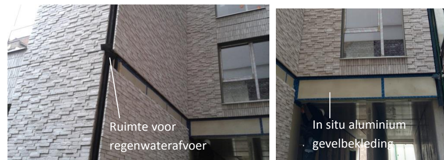
Figuur 78 Uitsparingen voor de regenwaterafvoerbuïs en de aluminium bekleding
