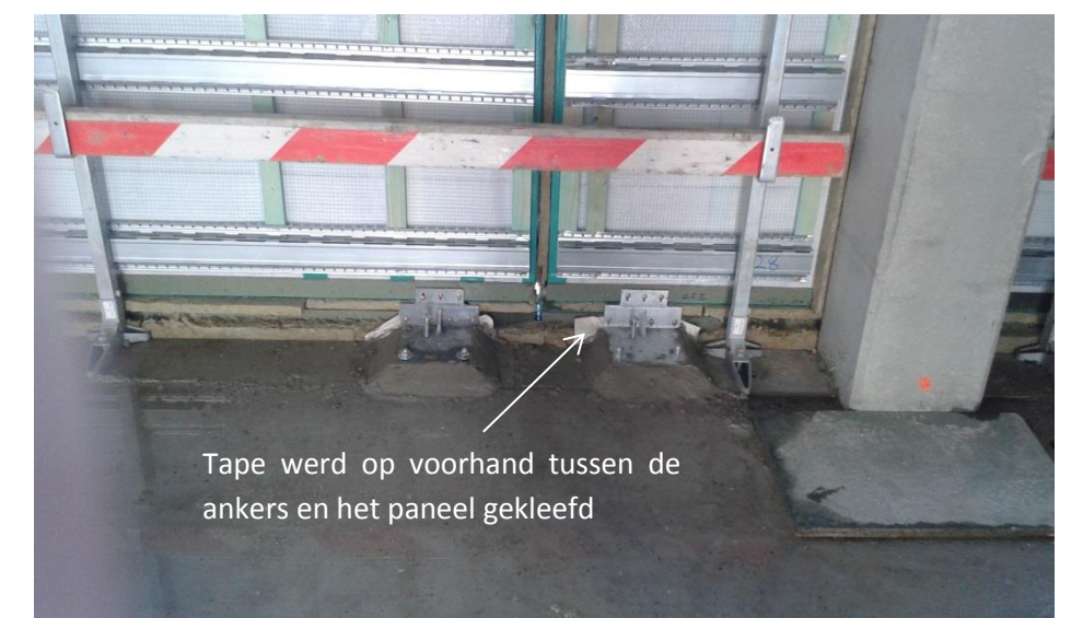
Figuur 60 Tape achter de ankers
