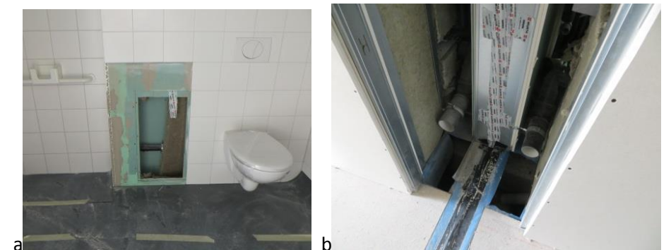
Figuur 91 (a) Prefab badkamer (b) Voeg tussen containers
