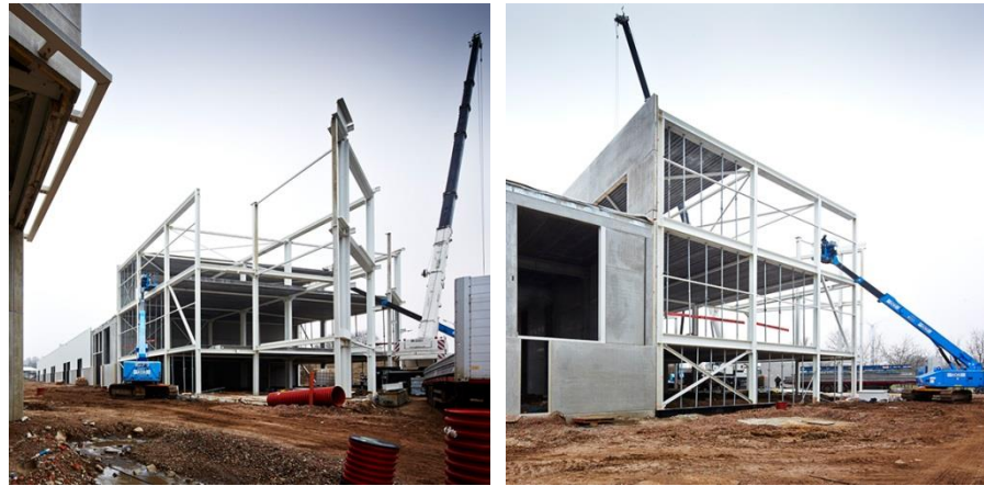
Figuur 63 Staal skelet met betonnen SIP's (Futurn, 2017)
