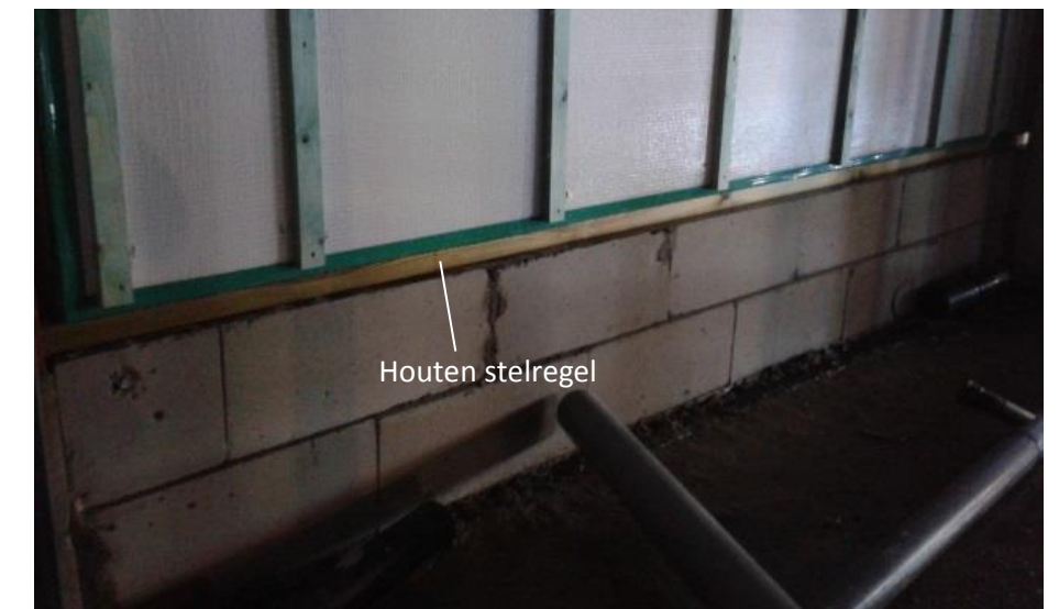
Figuur 59 Stelregel in hout met beton-metselwerk tegen de kolommen.
