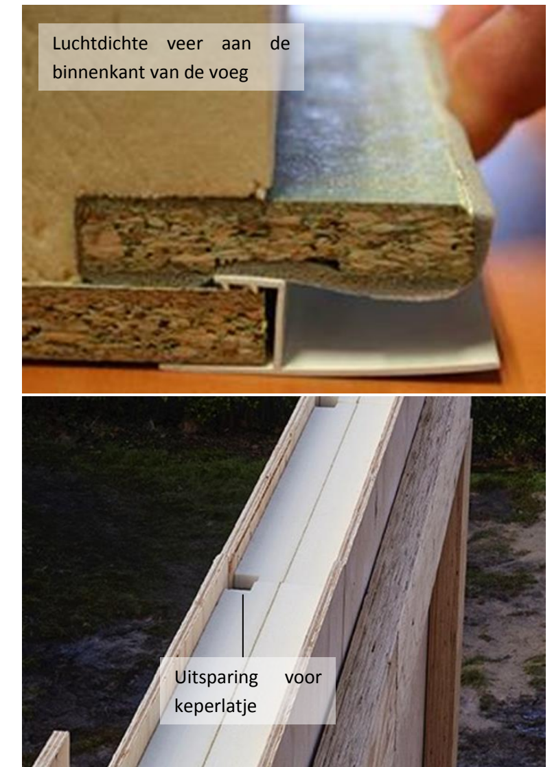
Figuur 34 Boven: uitsparing voor de keperbalkjes Onder: Luchtdichte veer (houtvezelplankje met PVC-foam).
