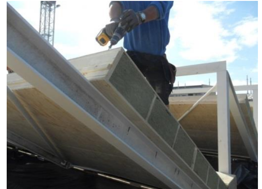
Figuur 25 De SIP-panelen werden vastgeschroefd aan de stalen structuur
