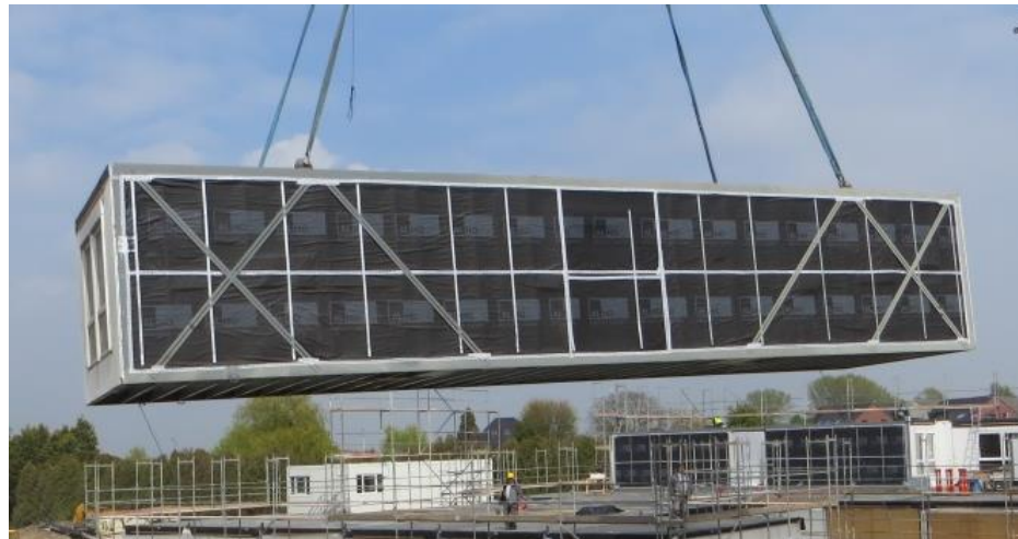
Figuur 93 Tijdelijke versteviging (schuine schoren) om vervormingen tijdens transport en montage te vermijden
