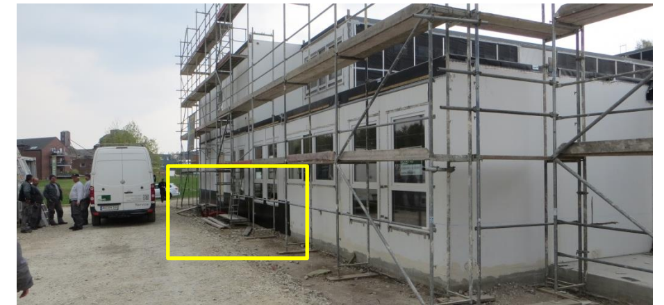
Figuur 90 In-situ aangebrachte bitumenlaag om vocht opstijging in de module vanuit de grond te voorkomen
