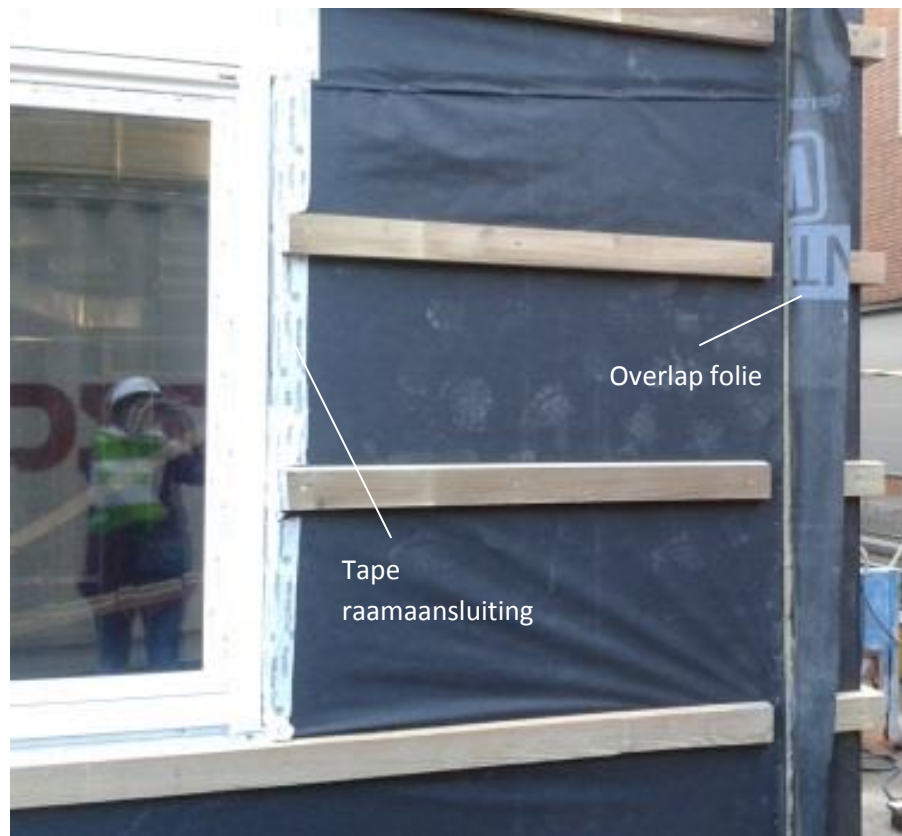
Figuur 62 Buitenkant HSB-panelen met dampopen folie en geïntegreerde ramen. De horizontale latten zijn afgeschuind om waterstagnatie te vermijden
