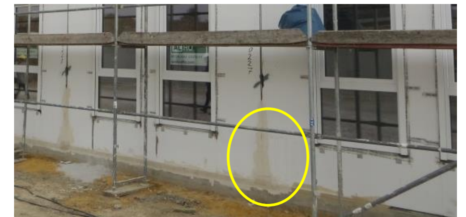
Figuur 92 Opvoegen voeg tussen modules
