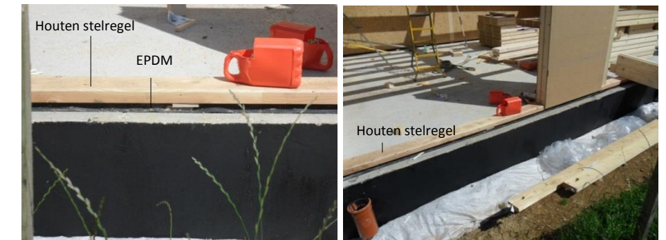
Figuur 30 Plaatsing op de stelregel
