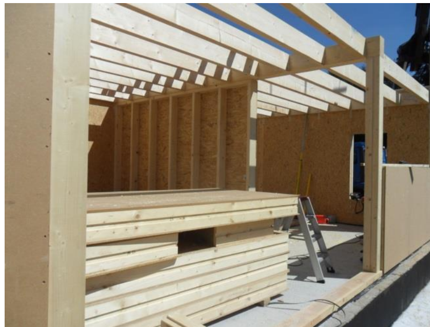
Figuur 28 Gelamineerde houten balken en liggers als draagstructuur. De binnenwand bestaat uit een houten roostering met OSB-plaat, eveneens geprefabriceerd
