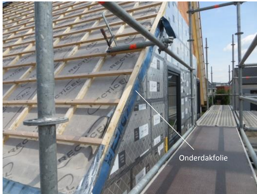
Figuur 20 Stuk onderdakfolie tegen de rand van de dakelementen
