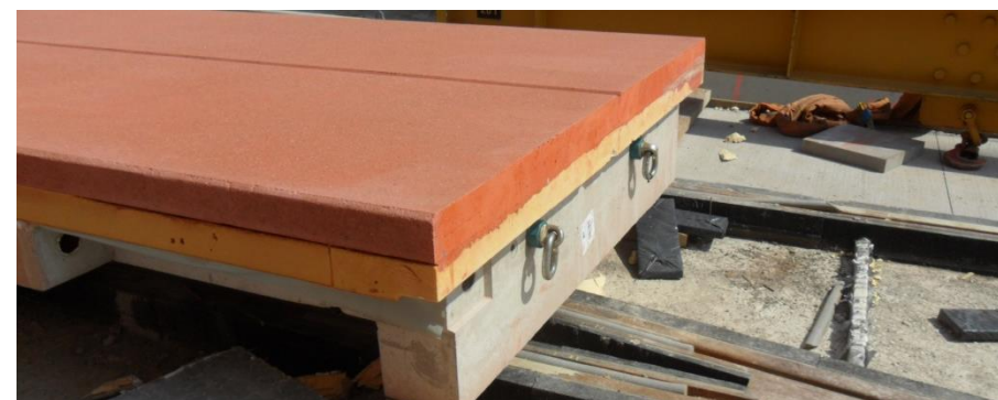
Figuur 72 Hijsogen aan de korte kant van het betonpaneel
