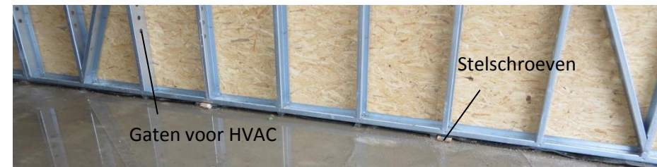
Figuur 3 Onderregel staalframe met EPDM en stelschroeven
