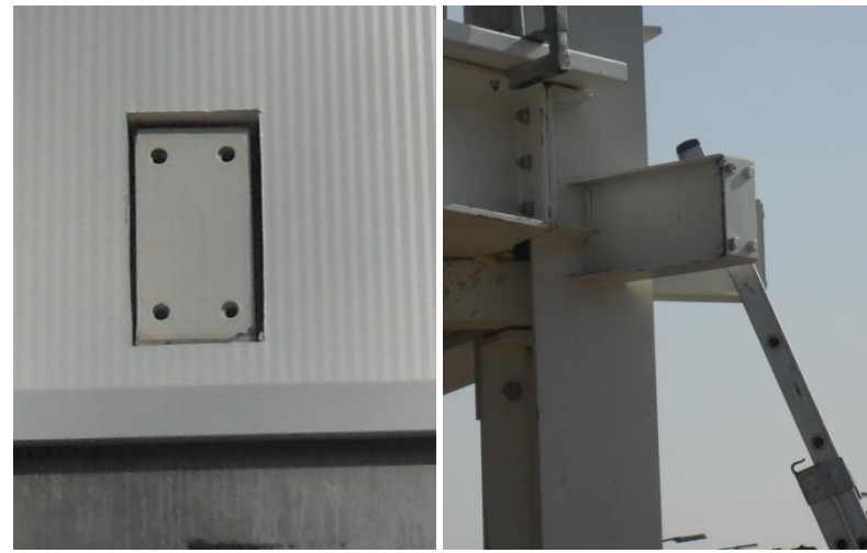
Figuur 65 Kunststofplaat voor verankering lamellen gevel
