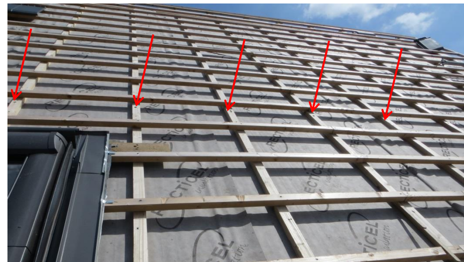
Figuur 16 Buitenoppervlak L-ments. De verticale tengellatten zijn prefab aangebracht
