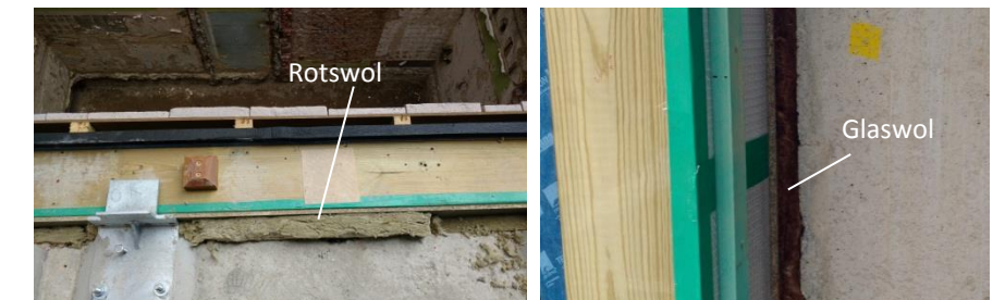
Figuur 79 Rotswol en glaswol bij de aansluiting tussen de houten gevelementen en de betonnen draagstructuur
