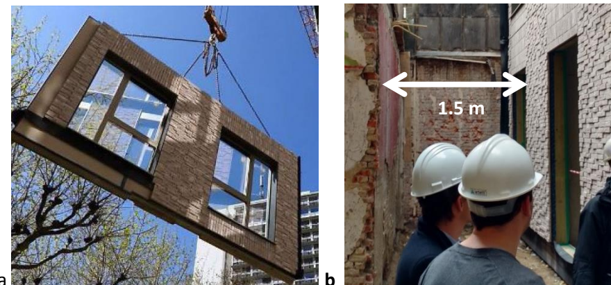
Figuur 77 (a) Paneel met schrijnwerk (b) beperkte ruimte achteraan om panelen te manoeuvreren
