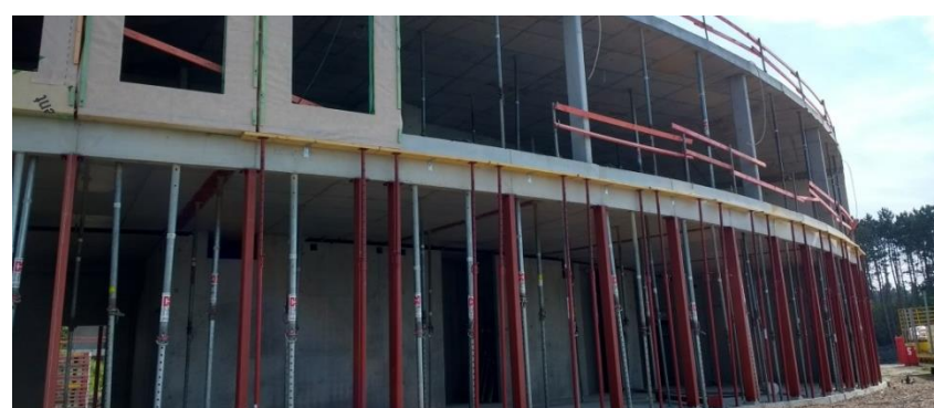
Figuur 51 Verplaatsbare stelregel op schoren
