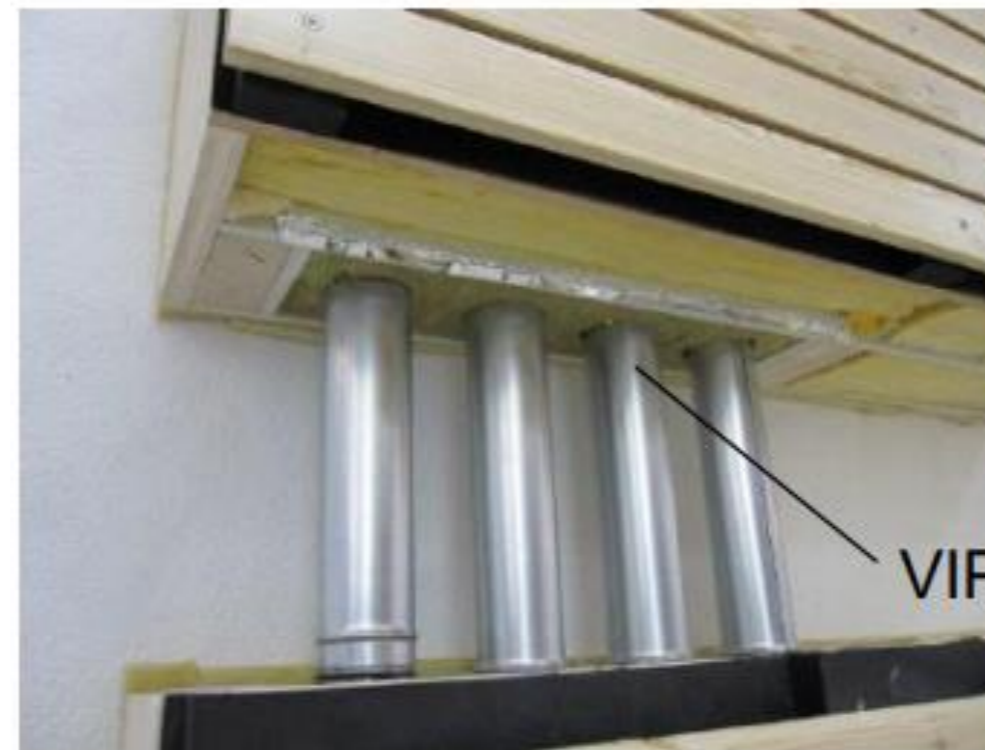
Prefab-raammodule met ventilatiekanalen, Annex 50
