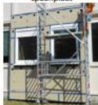
1.1 Houten caisson met cementgebonden spaanplaat
