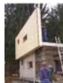
1.3 Houten caisson met vezelplaat en geventileerde gevel
