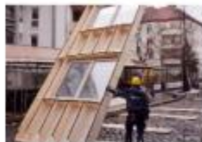
1.2 Houten caisson met gipskartonplaat
