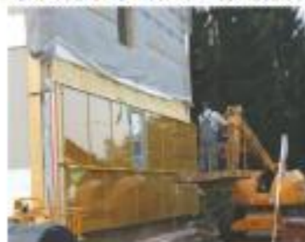
3.1 Houtskeletelement met gevelafwerking en ventilatie-unit met warmtewisselaar
