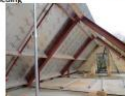
4.3 Isolatieplaat met meerlaagse aluminium bekleding
