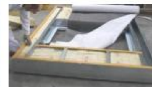
3.5 Staalframe met isolatie en luchtdichte laag
