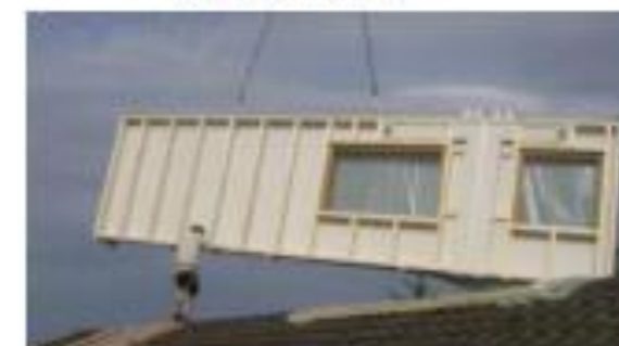
1.4 Houten caisson met houtvezelplaat en ventilatiekanalen
