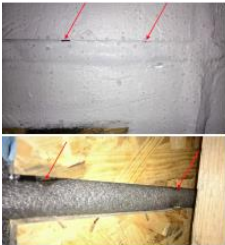
Opstelling 1: samendrukken backerrod
