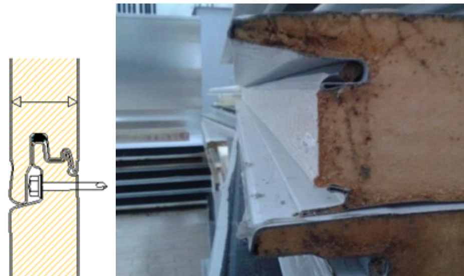
PU-schuimkern met PE-film
