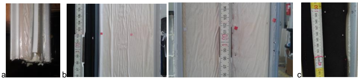
Figuur 20 (a) Te korte polyethyleen band in de tand-en-groef voeg (b) waterindicatorstickers op het tandvlak van foto (c) lokale schade aan de opencellige EPDM in de groef.
