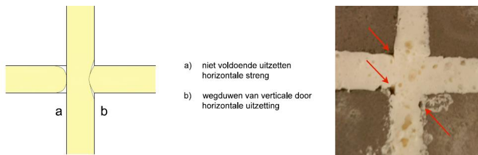
Figuur 30 Uitharden van PUR bij kruispunten (Van Linden, Solar Decathlon - Aansluitingen van prefabpanelen bij de renovatie van naoorlogse woontorens (Masterproef), 2016).
