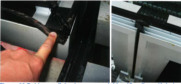
Figuur 33 Rubber profielen in raamaansluiting (Geerlings, Kuindersma, & Niemand, 2013)
