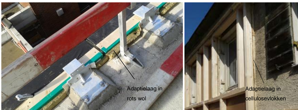
Figuur 1 (a) Adaptielaag in minerale wol, 4 cm (Case 9, Prefabgids) (b) Adaptielaag met cellulosevlokken (TES EnergyFaçade, 2010-2013)
