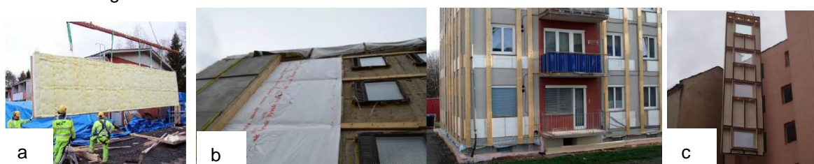
Figuur 6 (a) Gesloten prefab paneel met adaptielaag (b) gevel waarbij een substructuur in houten balken aangebracht werd (c) Open systemen waar achteraf isolatie in geïnjecteerd wordt (Dubois & De Bouw, 2015)
