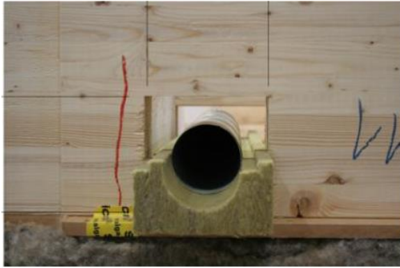
Figuur 15 (a) Installatie van het kanaal in een rotswol-mal. (b) Tijdens de plaatsing wordt het bovenste paneel tijdelijk hoger gehouden om de connectoren te kunnen plaatsen (Kobler, Dott, & Heim, 2012)
