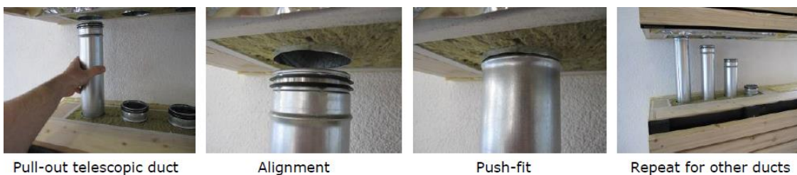
Figuur 6 Push-fit systeem om leidingen geïntegreerd in panelen te verbinden
