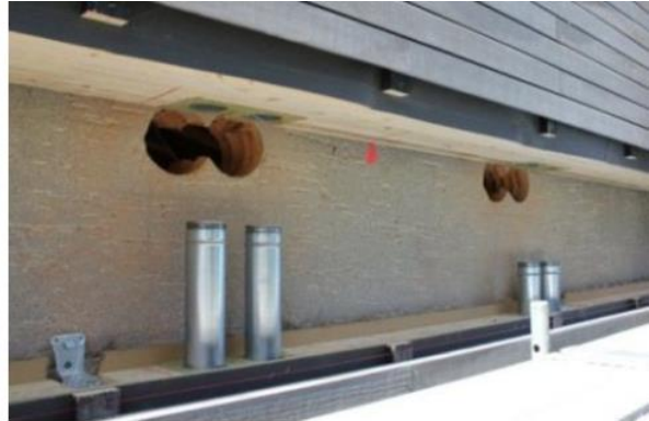
Figuur 15 (a) Installatie van het kanaal in een rotswol-mal. (b) Tijdens de plaatsing wordt het bovenste paneel tijdelijk hoger gehouden om de connectoren te kunnen plaatsen (Kobler, Dott, & Heim, 2012)
