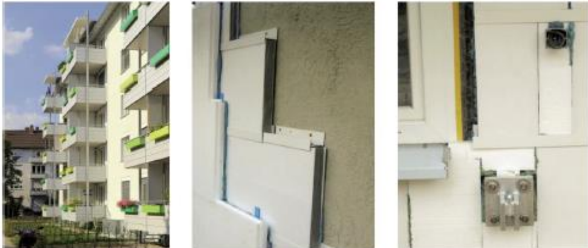
Figuur 4 Gevel in Karlsruhe (2010): bevestiging VIP's met aluminium rail. Aan de buitenzijde van de VIP-laag werd nog een EPS-laag van 25 cm voorzien (Johansson, 2012).
