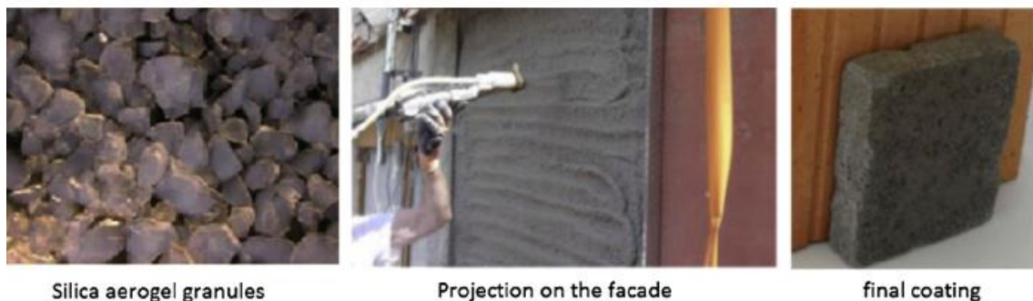
Figuur 14 Aerogels in een cementering (Ibrahim, Biwole, Wurtz, & Achard, 2014)
