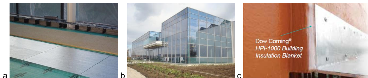
Figuur 1 (a) VIP-paneel in een vloer-constructie (Promat) (b) VIP paneel in de opake delen van een gordijngesvel (Promat) (c) Gebruik van een flexibele aerogelstrip in de aansluiting van een metalen zonnepaneel aan de gevel (DowCorning).
