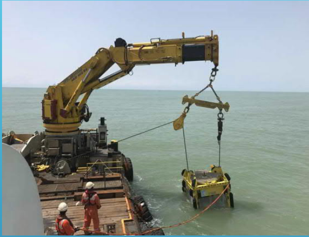
Mini CPT geotechnical investigations
