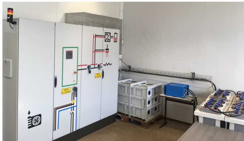
Figuur 2.3: Weergave van het hybride opslagsysteem
