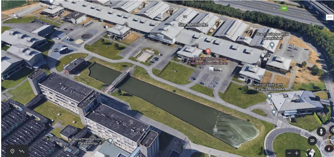
Afbeelding 4.59: 3D-beeld van het noordelijk deel van de site Dierengeneeskunde (Google Earth, 2021).
