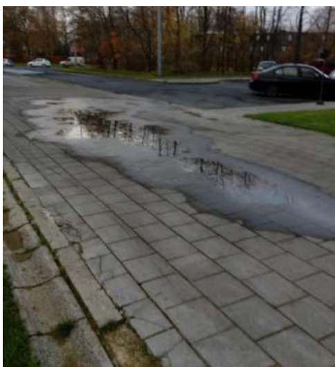
Figuur 39: Voorbeeld onnodige verharding
