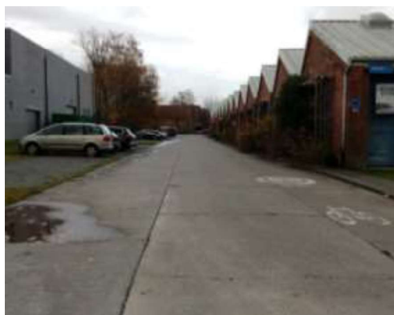
Figuur 40: Voorbeeld onnodige verharding
