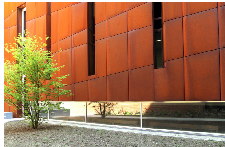
8. De oorspronkelijke stijl van het historische gebouw krijgt hier en daar een hedendaags jasje. Zo bestaat de gevel van de westvleugel uit cortenstaal, een duurzaam en weerbestendig materiaal.
